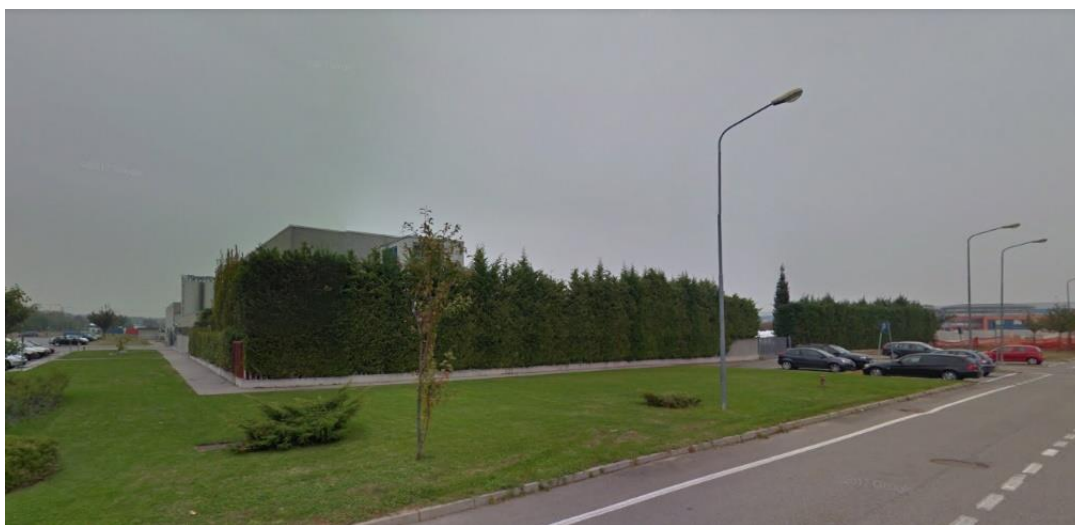
Figura 6: Vista impianto da sud
